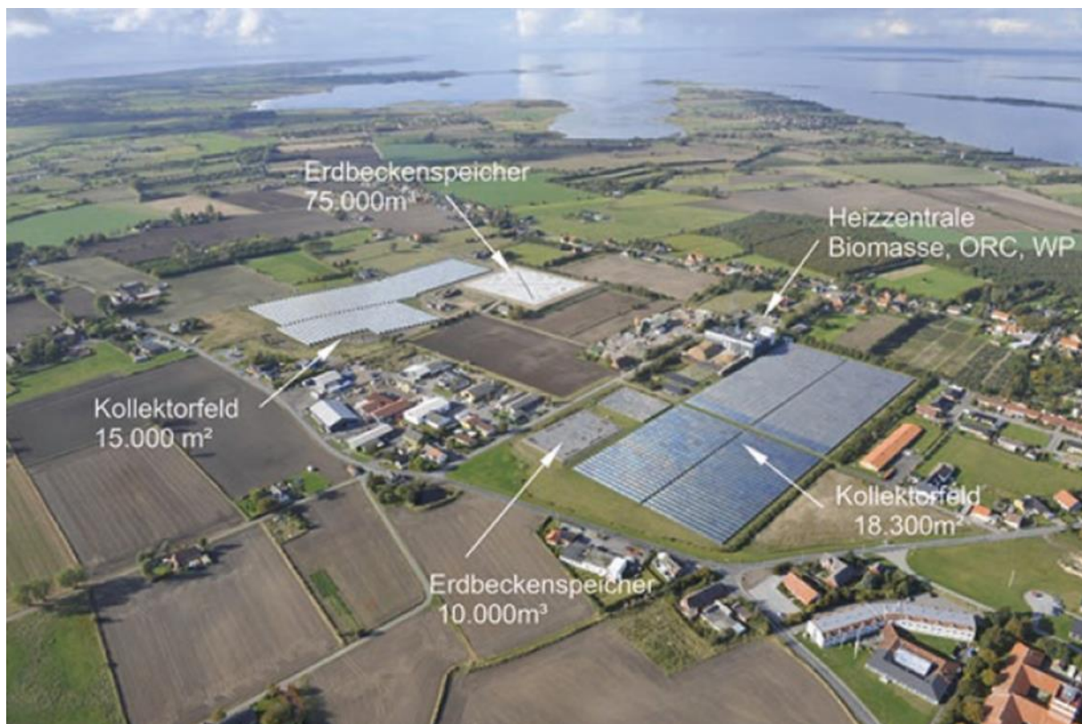
Abbildung 3: Luftaufnahme der solaren Fernwärmanlage in Marstal
