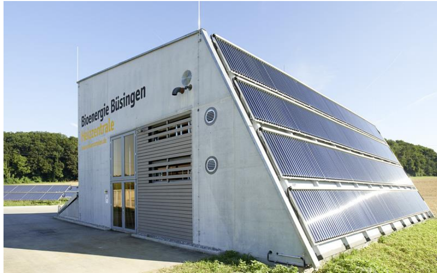
Abbildung 2: Heizzentrale und Freiflächenkollektoren im Bioenergiedorf Büsingen
